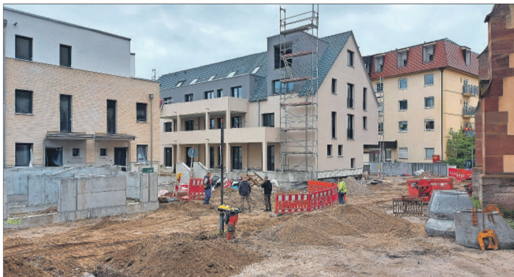
Seit Mitte April und bis voraussichtlich 11. Juni ist die Kirchstraße wegen ihrer Erneuerung gesperrt. In der Bildmitte das neue Mehrfamilienhaus, links zwei Stadthäuser. Foto: Ernst
